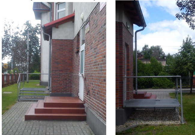
•schody zew. w elewacji frontowej
