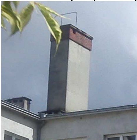
•widok na komin dymowy i na wentylacyjny
