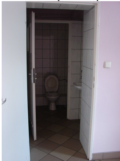
•widok na ściany w ubikacji
