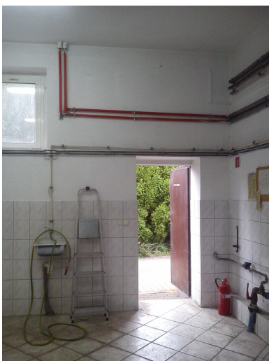
•drzwi do kotłowni
