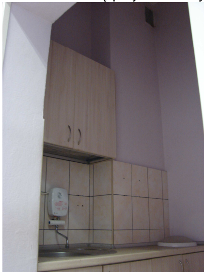
•widok na ścianę przy zlewozmywaku
