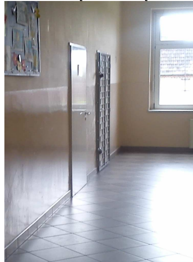
•drzwi z kratą metalową
